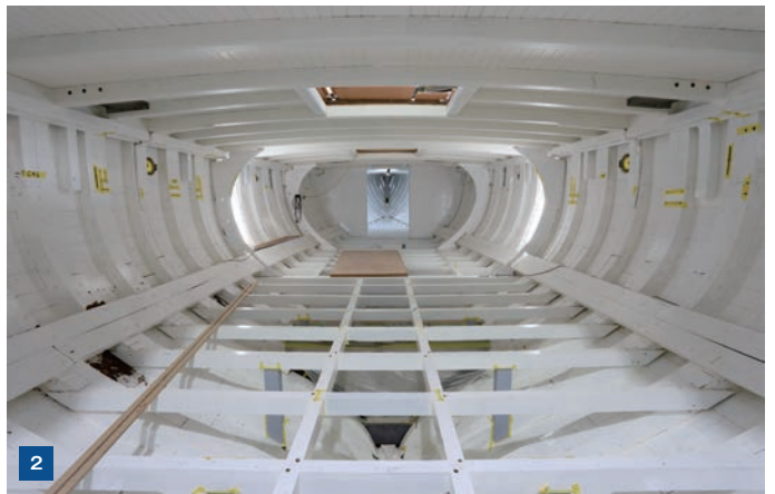
1. 見事に張りあげられたチークの外板。外板の保存状態は良く、9割以上はオリジナルの材を利用して張ることが出来た。 2. 2019年8月。船内後方から前方を見る。船殻(せんかく)の内部構造がよく分かる。水のタンクが据えられ、その上に床を支える梁が組まれた。
